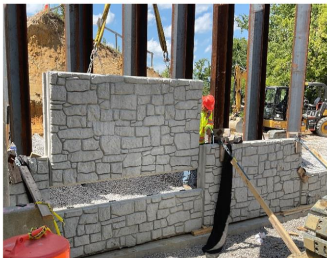
I-64 La Salle Ave Phase 1 MSE Wall
